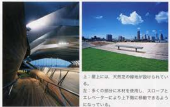
横浜港大さん横国際客船ターミナル[全長430m]2002 神奈川県アレハンドロ・ザエラ・ホロ[スペイン・1963～]、ファッド・ムサヴィイ[イラン・1905～] 横浜港大さん横国際客船ターミナルは、港と船との統合を考え、景観に配慮し高さを変えて設計された外観が特徴である。空に溶けた部分が大きく広がった開放的な空間として設計され、ターミナル内部には階段がなく、パブリックスペースを採用しているなど「誰のようなく、訪れる人に優しい」デザインになっている。
